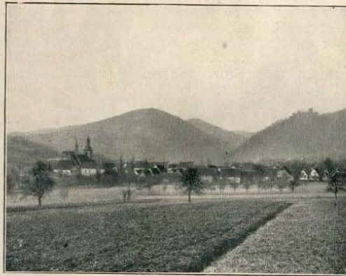
Gesamtansicht, rechts oben Bura Landef
